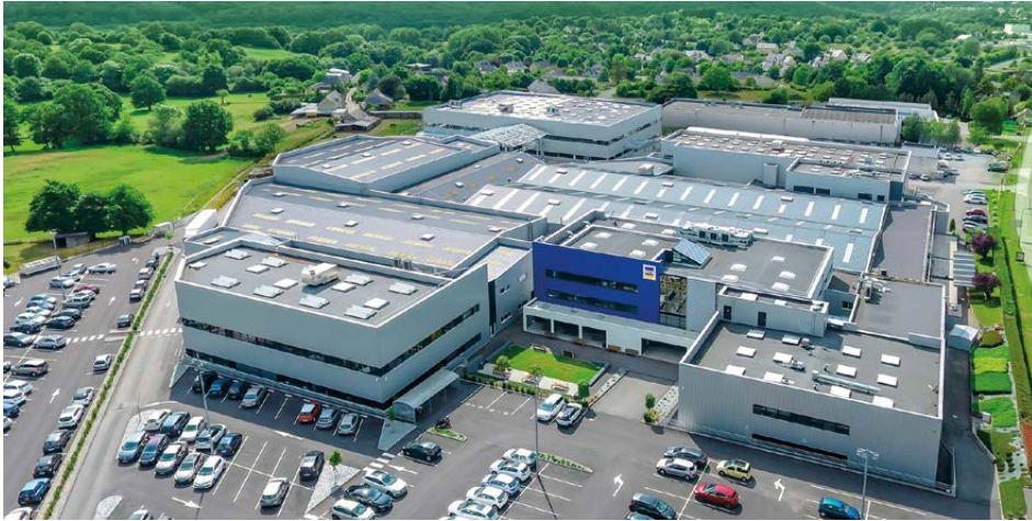
Les locaux de l'usine de Laval (Saint-Berthevin) sont gigantesques. Le groupe a décidé de s'appuyer sur une production verticalisée.
