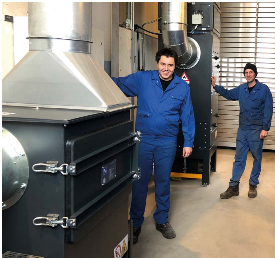
L'espace disponible derrière l'unité de découpe au laser est suffisamment grand pour permettre les travaux d'entretien sur le préséparateur d'étincelles et l'EXCube.
